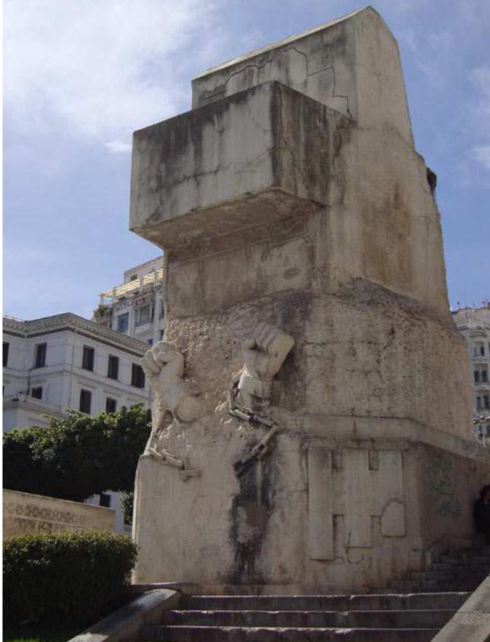
M. Issiakhem, bétonnage de 1978
